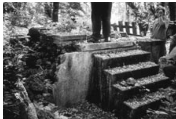
写真32 同前 本殿基壇、玉垣が一部崩れて残る。
