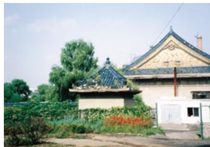
写真10 満州 旧新京(長春)に建てられた建国忠霊廟跡 現存する旧本殿、拝殿部分を裏側から見る。
