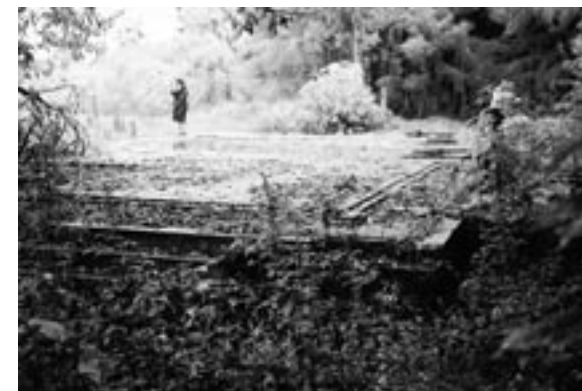
写真82 同前 旧本拝殿の基壇。病院の最後方、裏庭のような恰好になっている。
