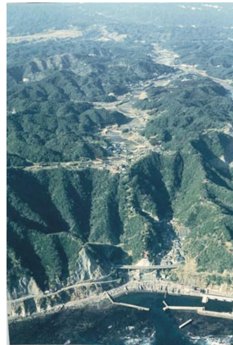
図 69 千葉県勝山市。これは陸あがりした漁村のむらだという。崖の上の家々と崖の下の浜に小さく並ぶ船とは無関係ではない。(87. 3)
