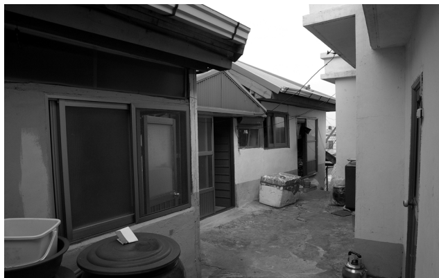
写真72 同前。旧社務所外観。左の建物が旧社務所である。外観は改装が甚だしくかつての面影はない。
