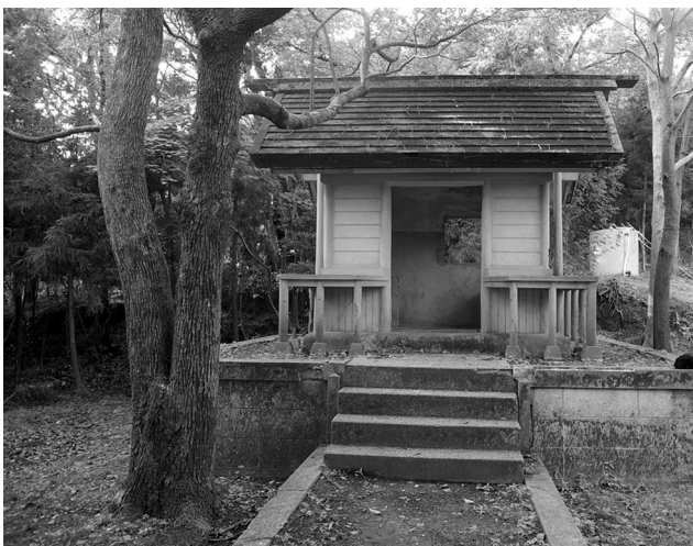
写真11 同前。本殿正面。屋根はスレート葺。
