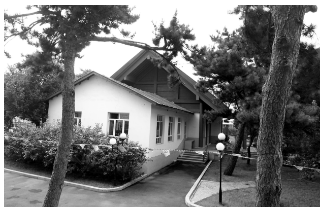
写真9 同前。旧新京神社拝殿南面。棟の高い旧拝殿の妻面に接続する白壁の棟の低い建物は後補であろう。
