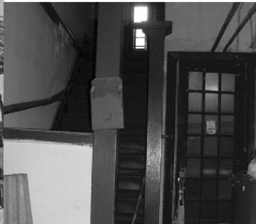
21-5 調査住宅階段部分
