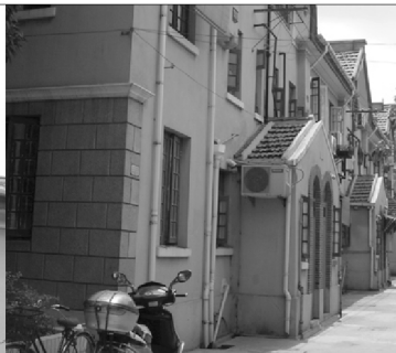
21-3 調査住宅外観北側
