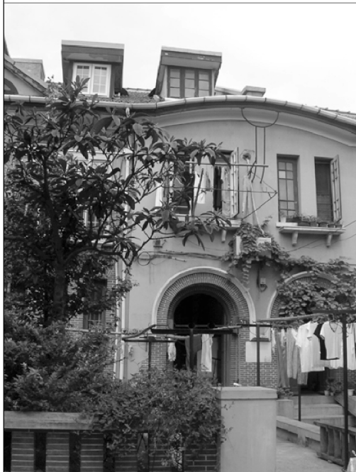
21-2 調査住宅外観南側
