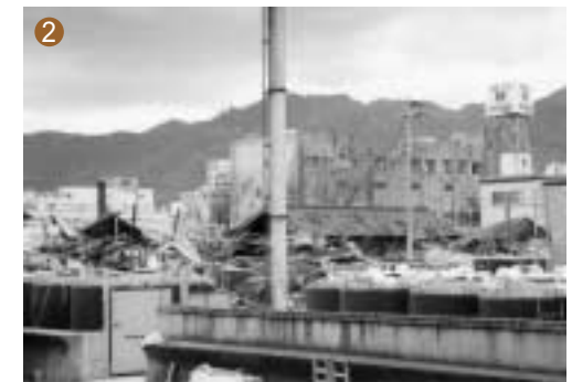
倒壊した酒蔵(兵庫県神戸市)
