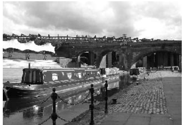
写真13 イングランド マンチェスターの水路
