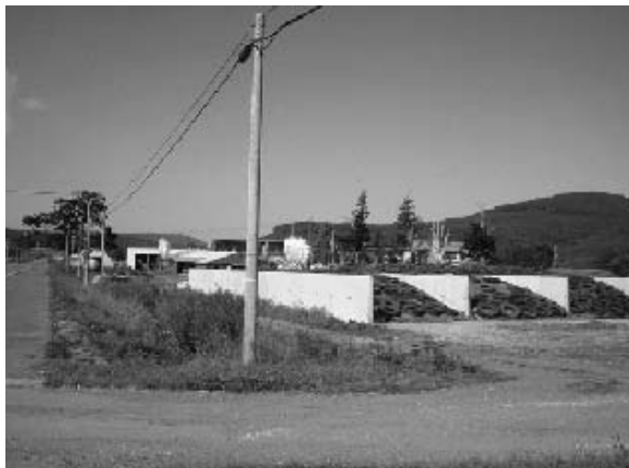
写真13 白く写るコンクリートの壁に挟まれる形で3基連続して設置されているものがバンカー。 (2005.9.29 紋別市藻別・筆者撮影)
