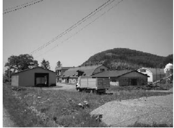
写真6 写真中央, プンカ屋根(奥側)に平屋の牛舎(手前)が接がれる。 (2005. 7. 13 興部町秋里・筆者撮影)
