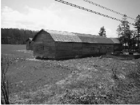
写真5 写真3と同じく同形を接ぐ事例。 (2005. 5. 16 興部町北興・筆者撮影)
